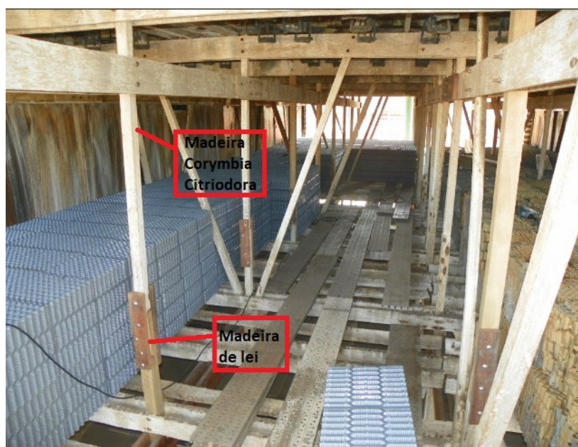
Foto 3. Reforma da estrutura com madeira Corymbia Citriodora tratada
