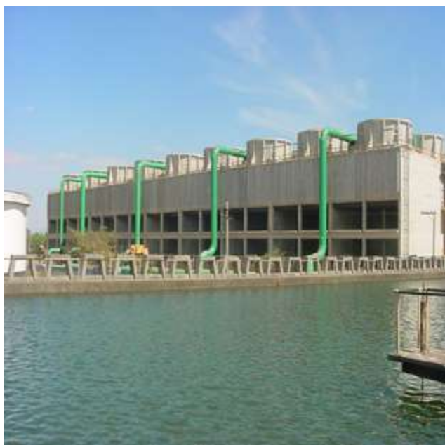
Figura 4 - Torre de refrigeração concluída e operando.
