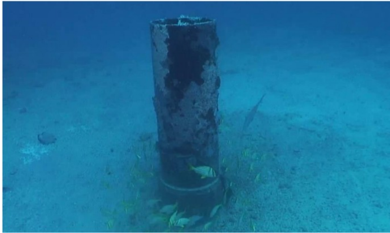
Figura 1. Visão geral da área do revestimento antes da intervenção
