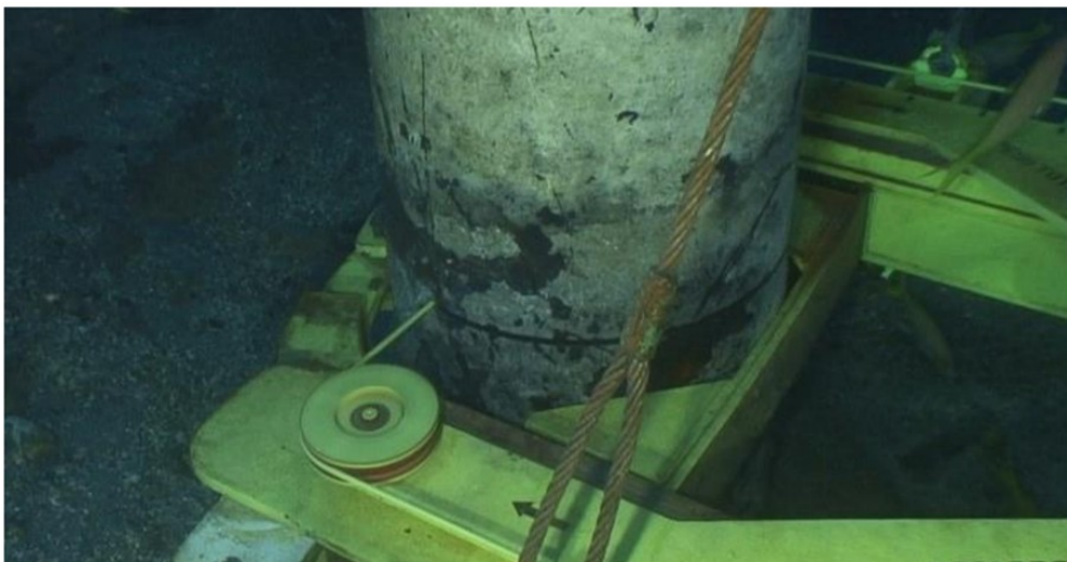
Figura 10. Corte em andamento
