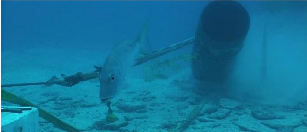
Figura 13. Revestimento sendo tombado
