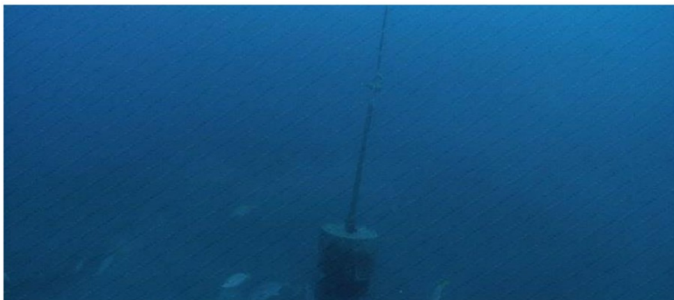
Figura 5. Cabo do guincho conectado ao olhal da capa de corrosão
