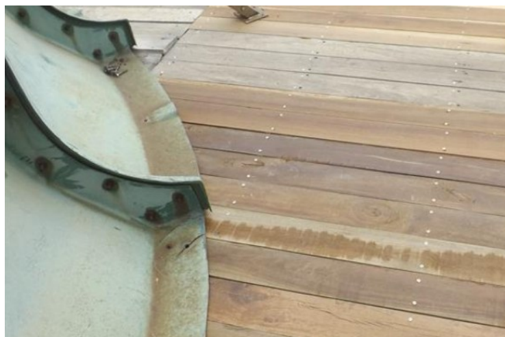
Foto 2. Reforma dos pisos com madeira Corymbia Citriodora tratada
