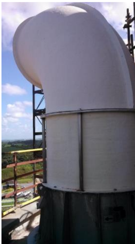
Figura 4 - Instalação dos motores.
