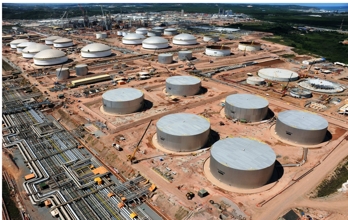
Figura 11 - Parque de tancagem de produtos finais da RNEST: diesel, nafta e óleo combustível.
