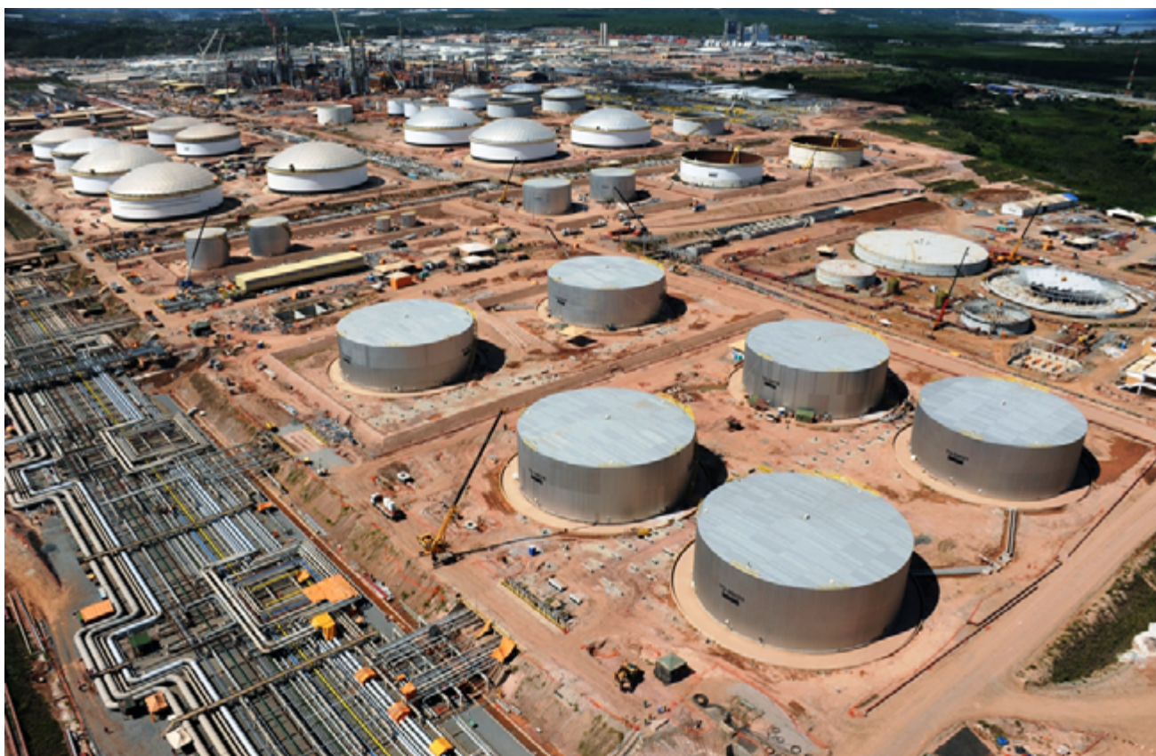
Figura 11 – Parque de tancagem de produtos finais da RNEST: diesel, nafta e óleo combustível.
